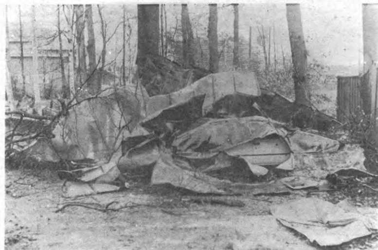
Tijdens de weekendstormen bezwaken nogal wat daken. Dit was ook het geval voor het "koperen dak" van het oude Sportgebouw. De schade kan u zelf opmeten. (foto Veto)
